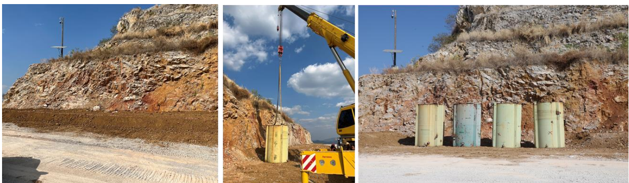
ภาพที่ 2 การติดตั้งถังบรรจุน้ำ
